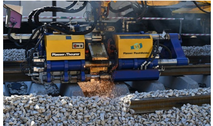
5: Plasser FlashWelder im Schweißensatz
