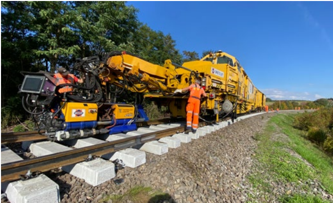
4: Baustelleneinsatz des Plasser FlashWelder am gleisgebundenen Trägerfahrzeug
