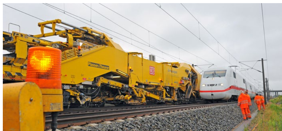
1: „Fahren“ und „Bauen“ sind vereinbar – Großmaschineneinsatz auf zweigleisiger Strecke mit vorbeifahrendem ICE Quelle: DB AG/Christian Bedeschinski
