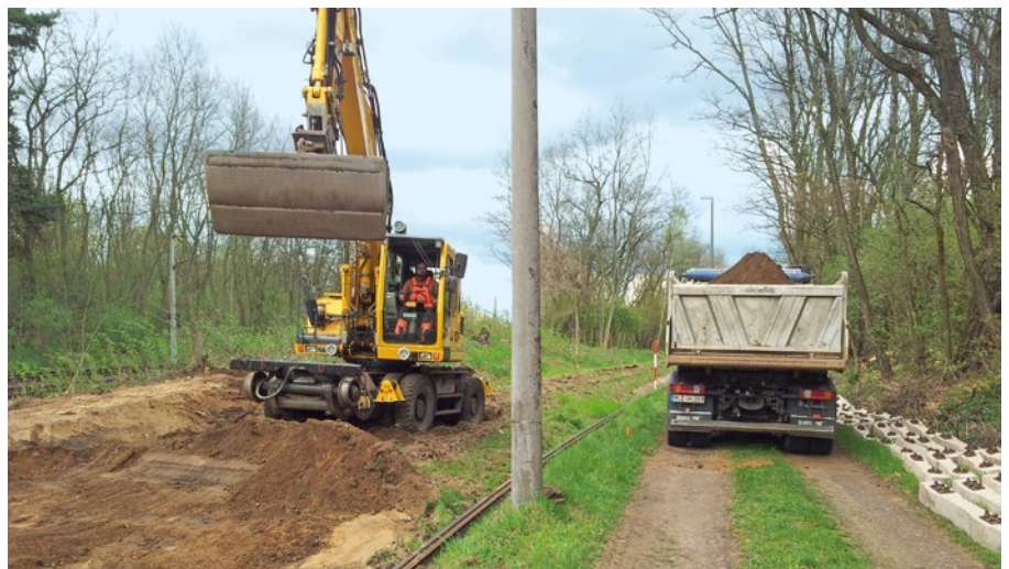
3: Konventioneller Gleisumbau mit Bagger, Lastwagen und Baustraße Quelle: Plasser&Theurer
