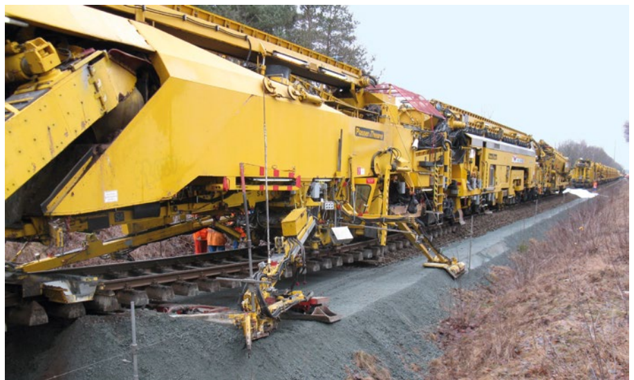
8: Planumsverbesserungsmaschine: Einbau der Planumsschutzschicht und darauf des Schotters
