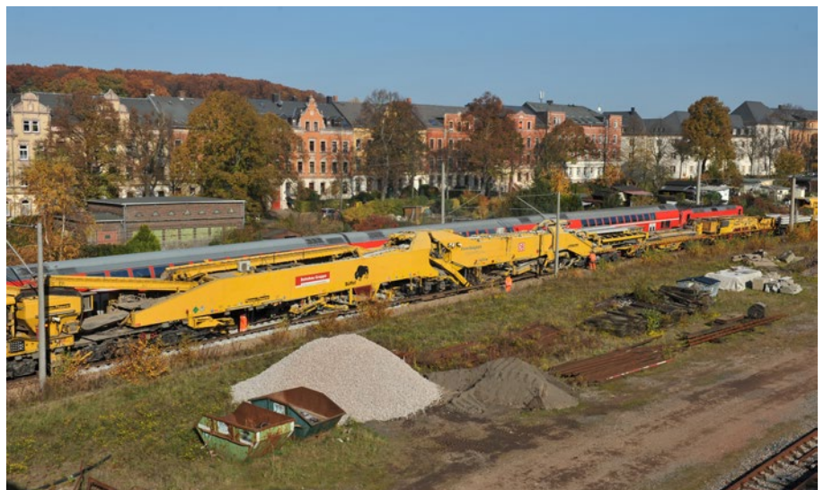
4: Typischer Großmaschineneinsatz auf zweigleisiger Strecke mit Aufrechterhaltung des Bahnbetriebes Quelle: Achim Uhlenhut
