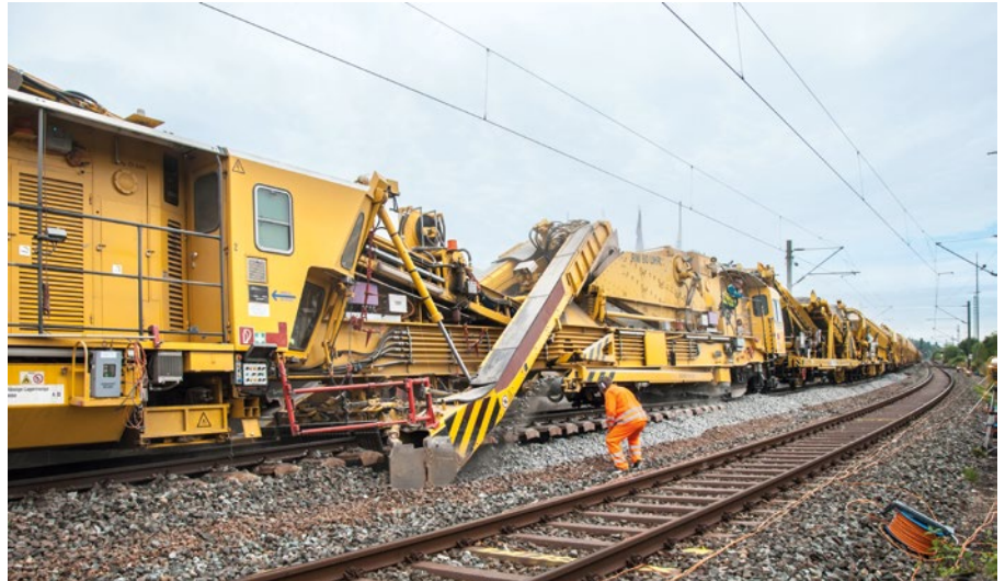
7: Bettungsreinigungsmaschine im Einsatz
