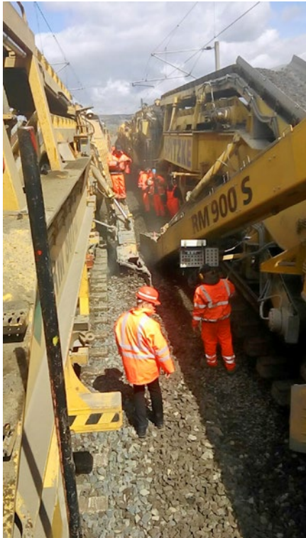
5: Begegnung zweier Reinigungsmaschinen beim gleichzeitigen Umbau beider Richtungsgleise. Sanierung der Schnellfahrstrecke nördlich Göttingen, aufgenommen vom Maschinenführer Quelle: Plasser&Theurer
