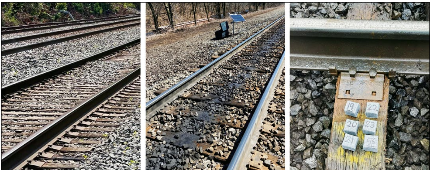
Abb. 3: Teststrecke mit sauberem (links) und verunreinigten Schotter (Mitte) und Smart Rocks vor dem Einbau (rechts)
