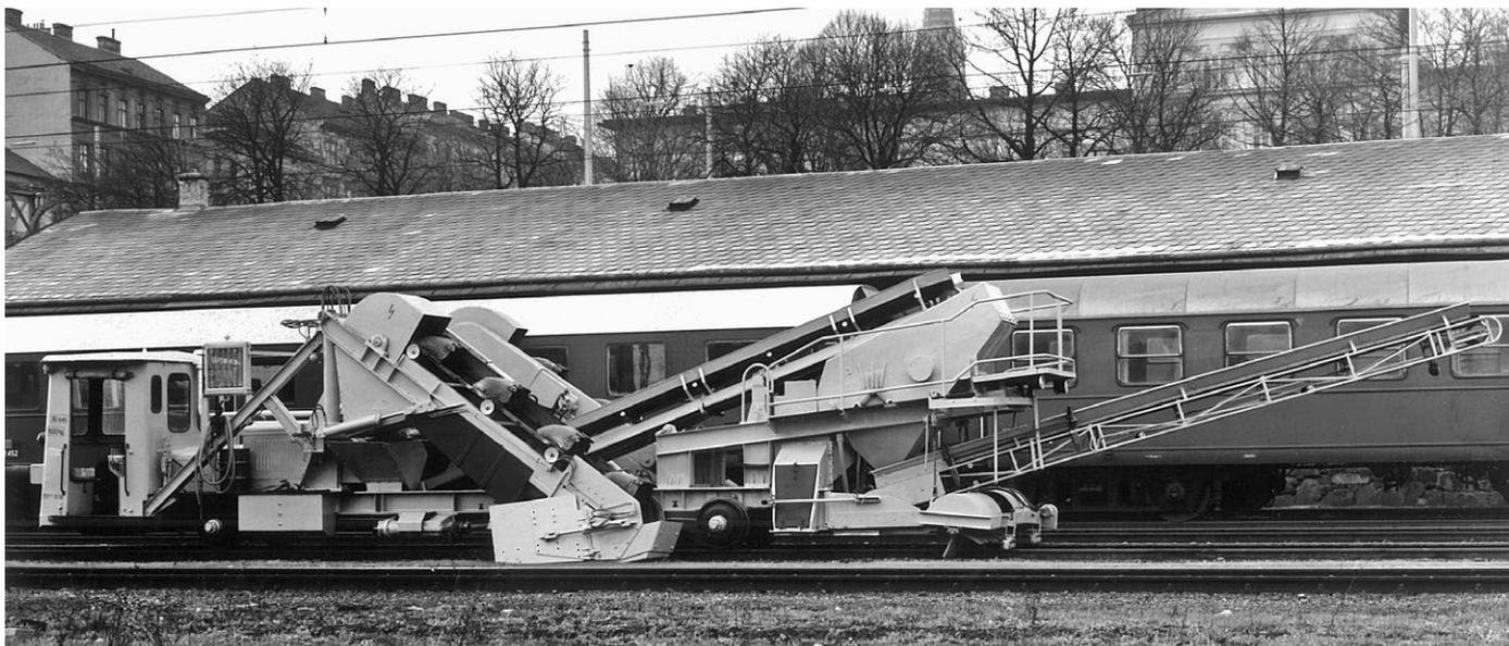
**Abb. 2:** Die SV51 war die erste Schotterverteiler- und Planiermaschine von Plasser & Theurer.
