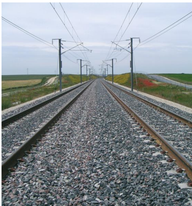
Bild 2: Zweigleisige elektrifizierte Eisenbahnstrecke mit Schotterbett
