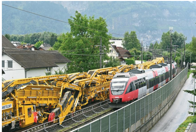
Bild 1: Das Fließbandverfahren direkt am Gleis mit Zugverkehr auf dem Nebengleis
